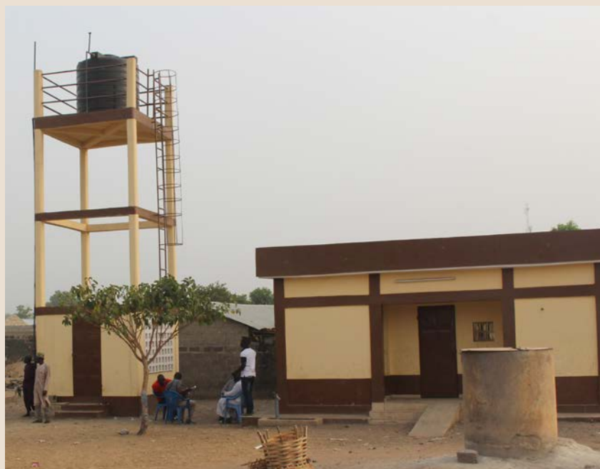
Latrines publiques et forages photovoltaïques à Kouboni (Tchamba)
